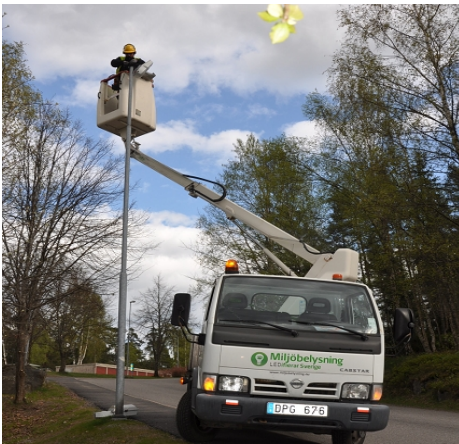
Miljöbelysning under arbete på Stora Hundensgata
